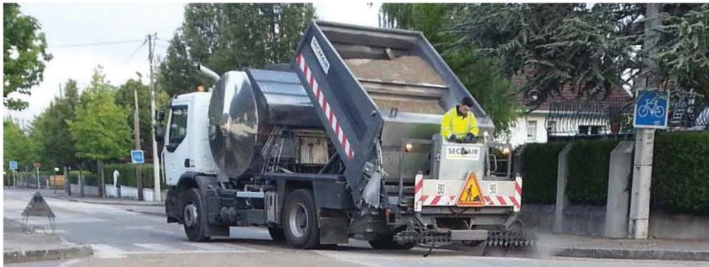
Le « point à temps » est une technique qui a pour objet **la réparation des couches de roulement des chaussées en des points où celles-ci ont subi des dégradations de surface** : nids de poule, arrachements, faïençages...
