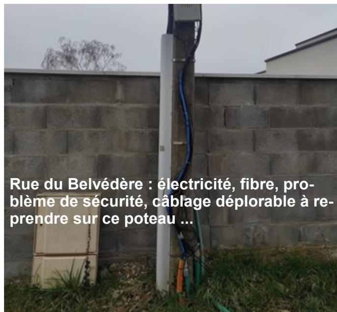
Rue du Belvédère : électricité, fibre, problème de sécurité, câblage déplorable à reprendre sur ce poteau ...
